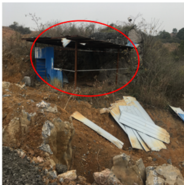
照片 4-1：拆除简易棚
