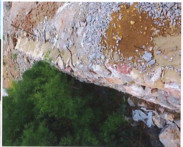
照片 4 矿山挡土墙
