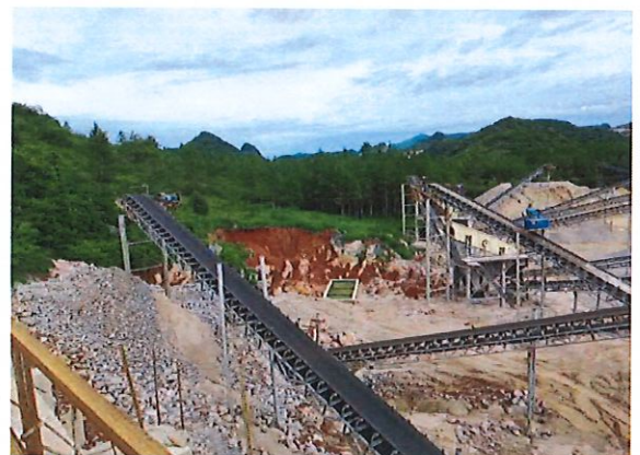
照片 6 矿山沉淀池
