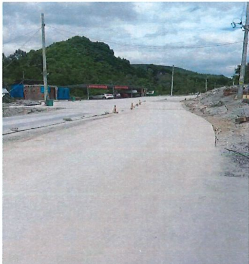
照片 3 矿山硬化公路
