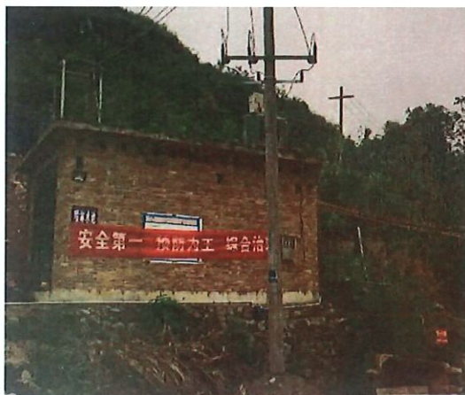
照片 8 变压器房与高水位池
