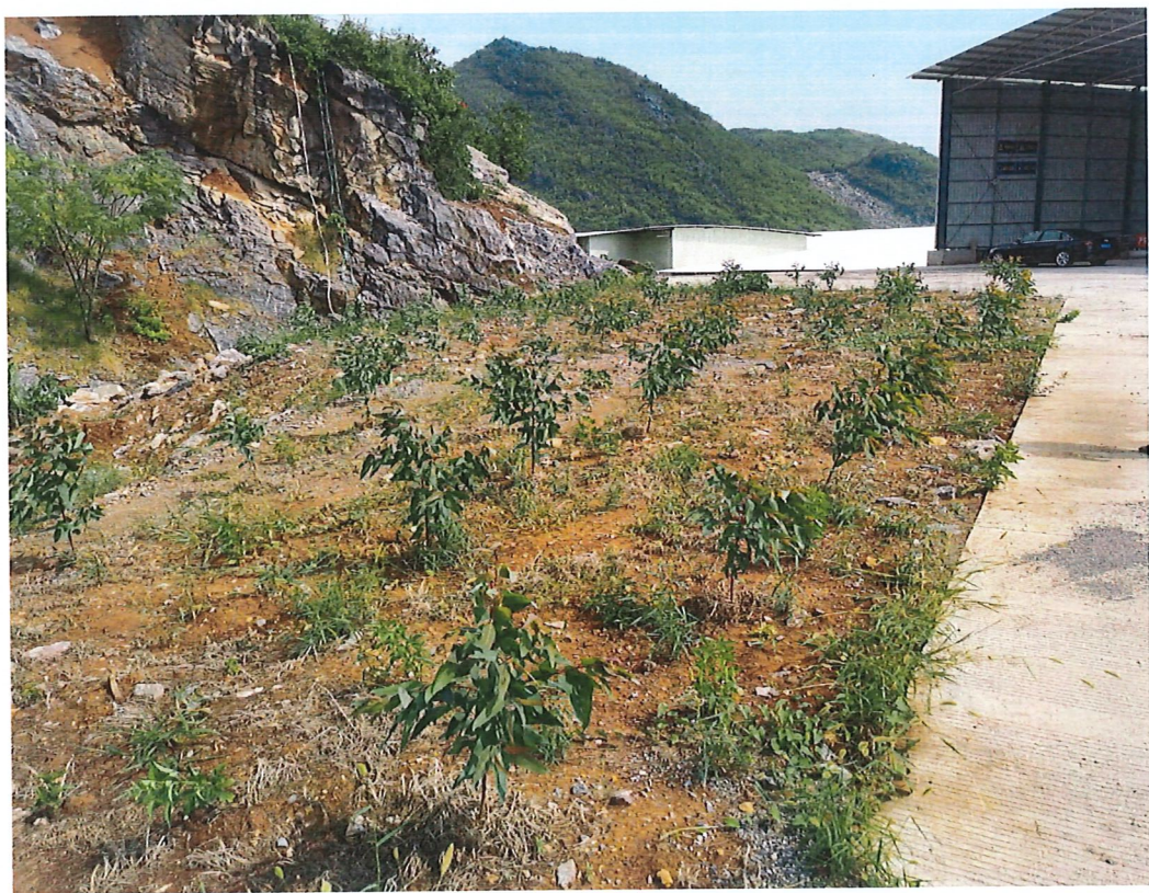
照片 6 复绿区现状
