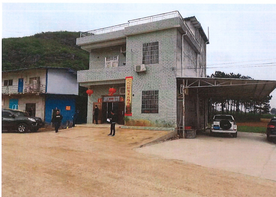
照片8 办公区现状
